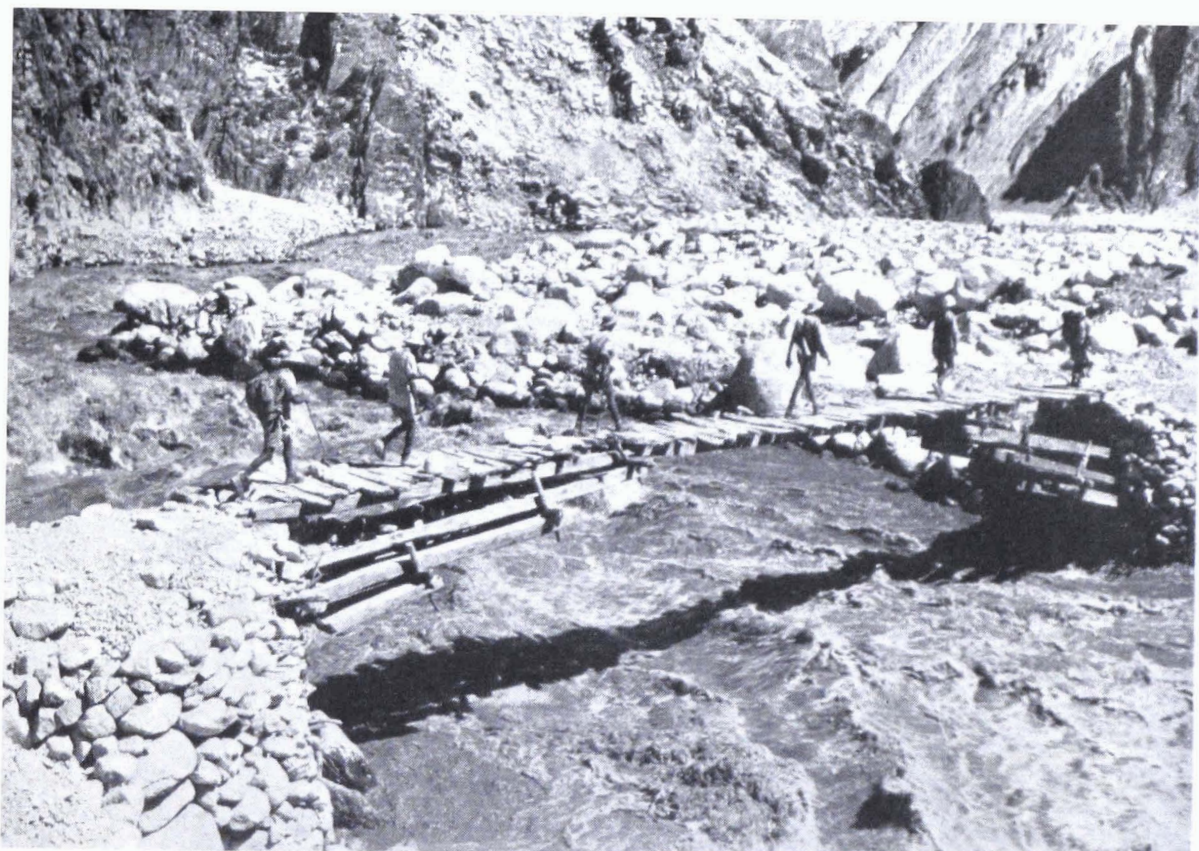
Bridge below Sussum.
